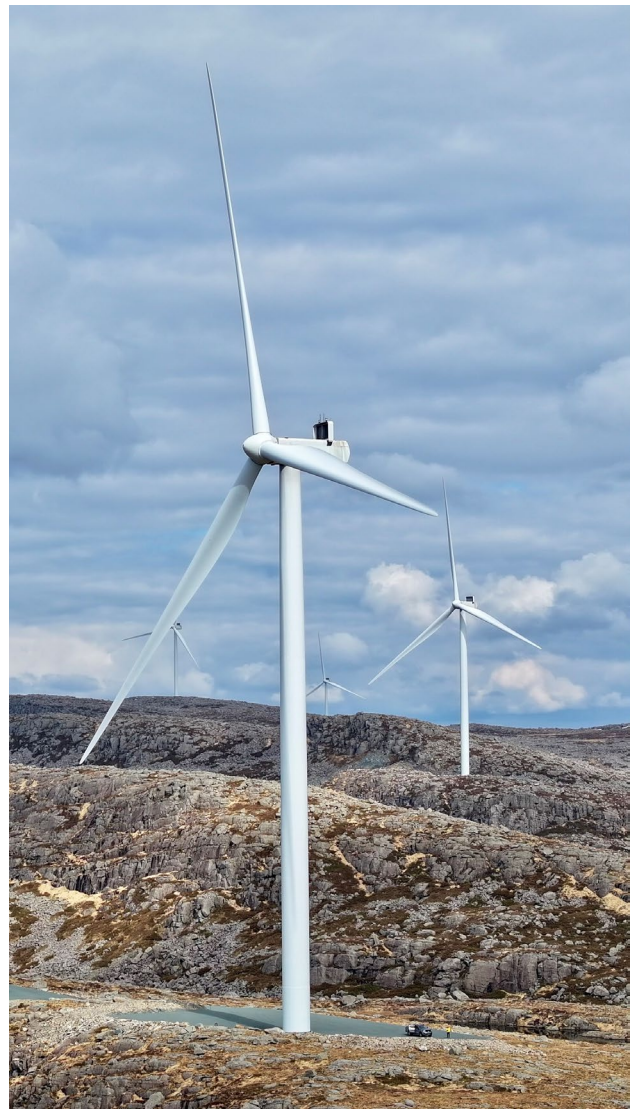
Figur 3-3 Eksisterende vindturbin i Guleslettene vindkraftverk. Foto: Eviny.
