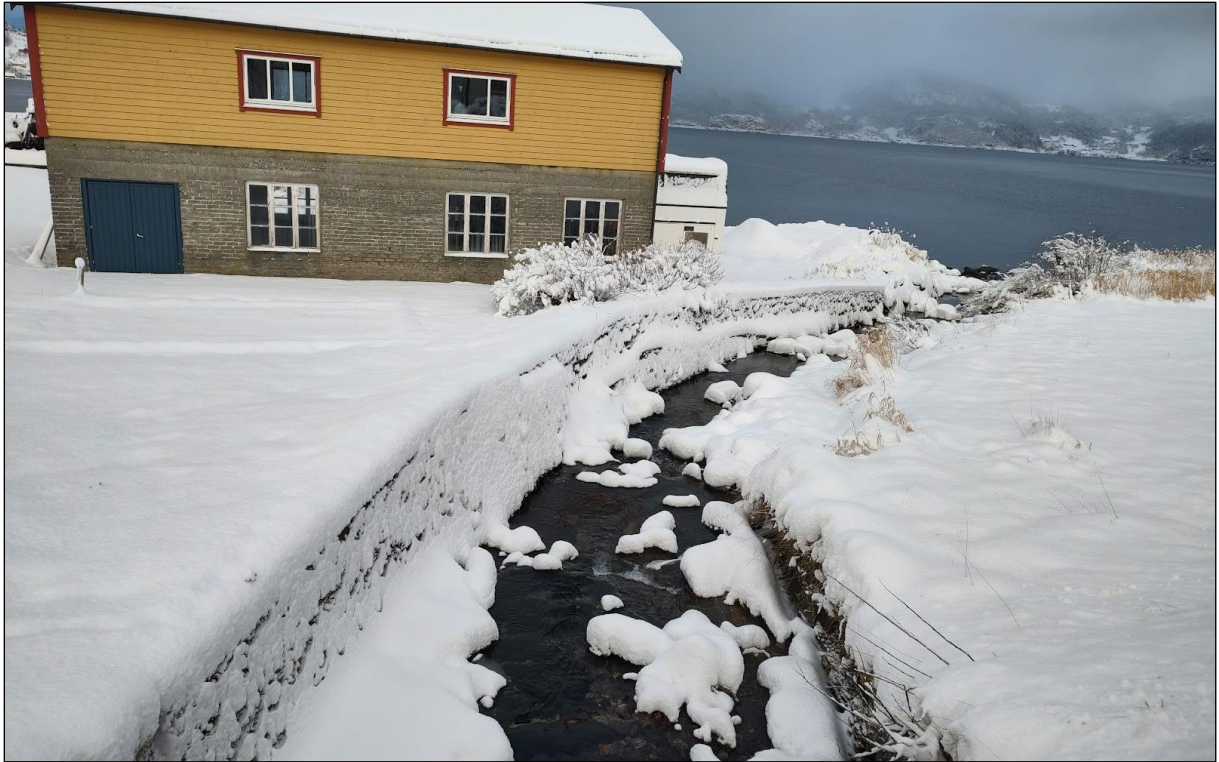
Figur 9. Sikret elveutløp øst i tiltaksområdet. Bygning er eldre fabrikkbygning.
