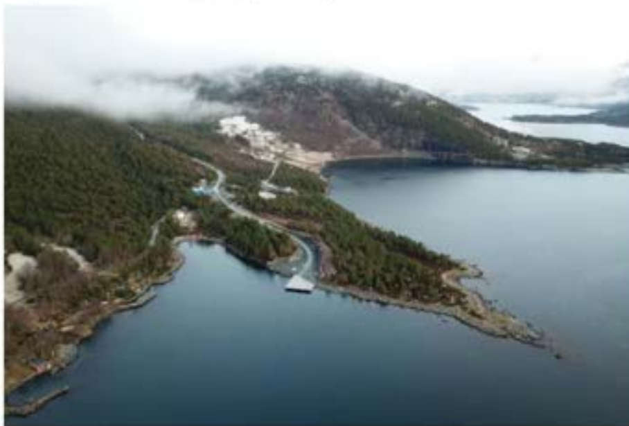
Figur 5-13: Kai ved Djupevika som er etablert i samband med utbygging av vindkraftanlegget på Marafjellet. Denne vil fungere som tilkomst for tungransport opp til Aksla.
