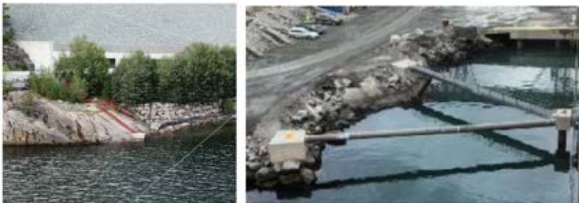
Figur 6-11: Eksempel på moglege fortøyingar mot land. Foto: Beheersmij Fr. Bontrup BV
