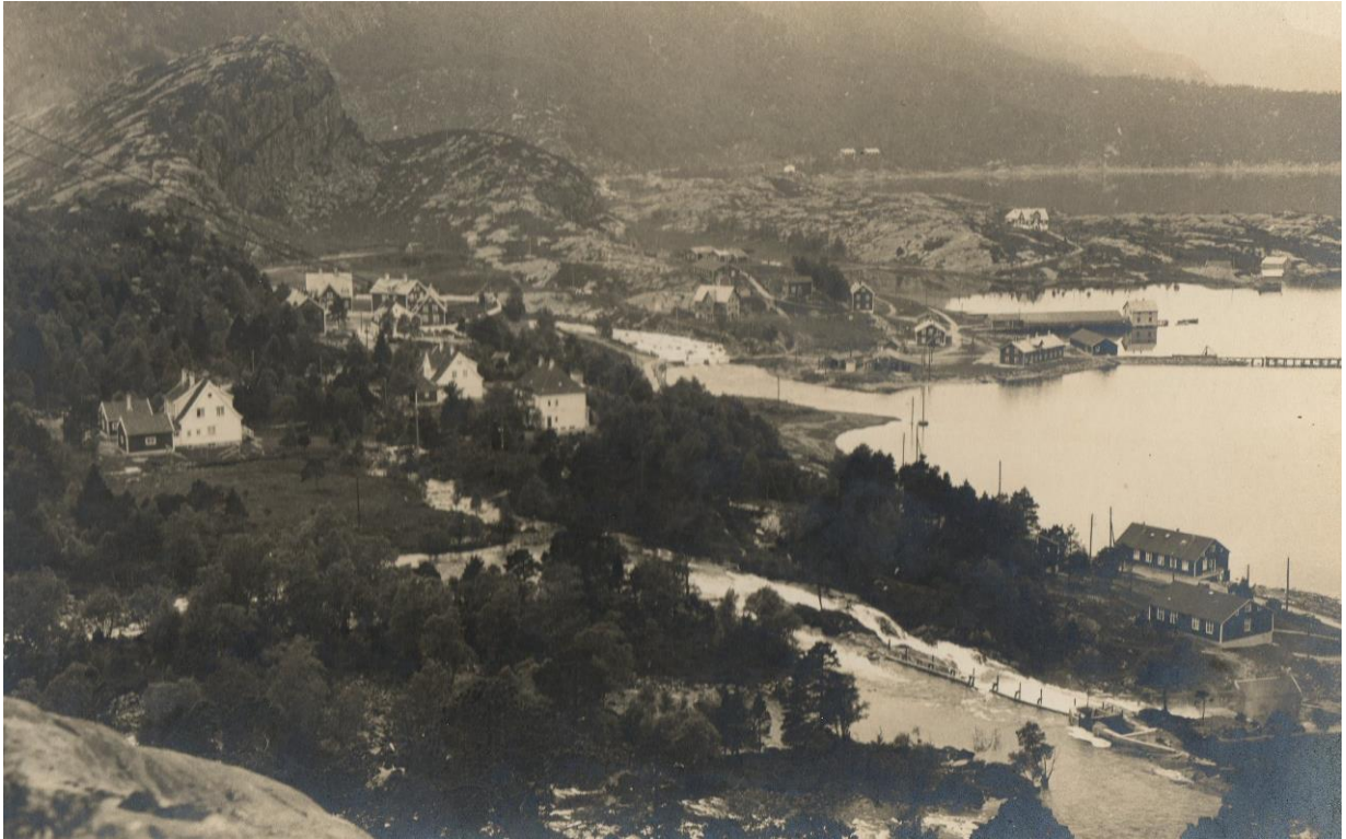
Svelgen med husa på Villabakken, ned mot Svelgselva, Øyra og «Realen» på Naustneset (Bygd i 1922)
