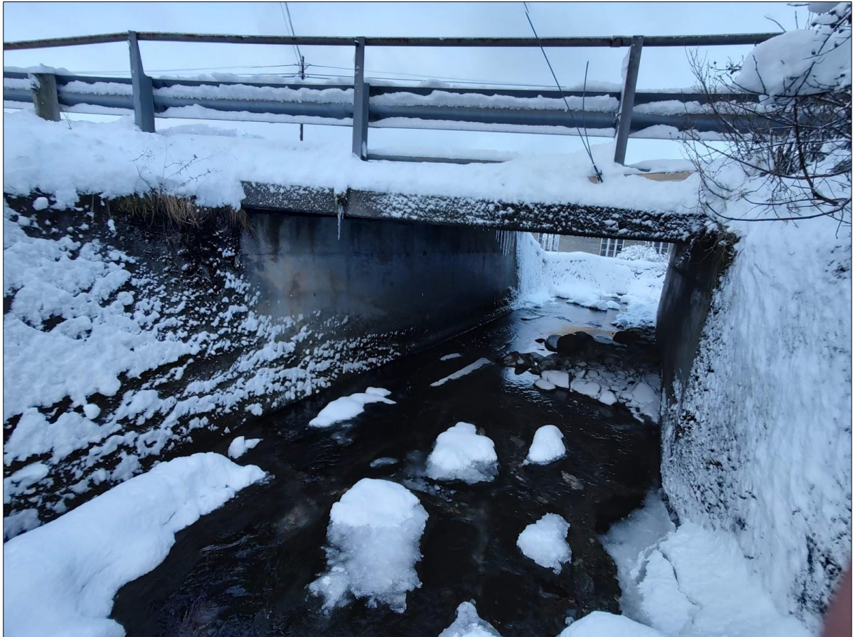
Figur 10: Broens lysåpning sett fra oppstrøms side av Fv. 616.
