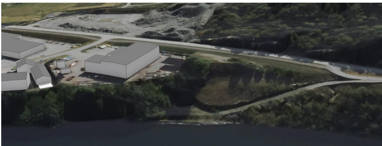
Figur 4-1: Illustrasjon av byggetomta slik den er i dag. Dagens situasjon. Kjelde: ArcGIS Norconsult.
